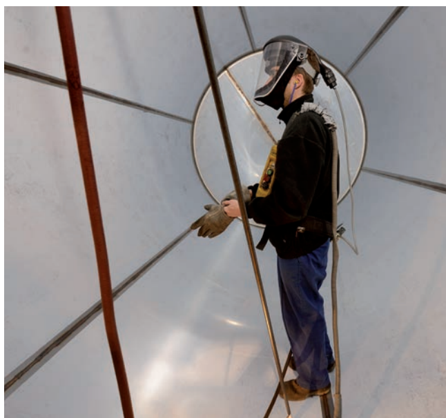
(Appareil de protection respiratoire isolant à adduction d'air comprimé avec cagoule
