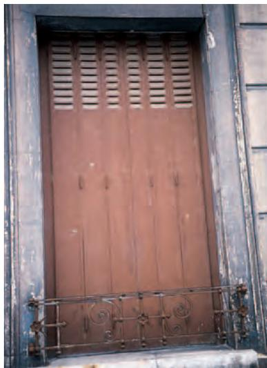
Fig. 3 – Minium de plomb ou plomb métallique sur subjectiles métalliques (garde-corps et volet)
