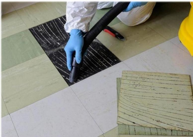
→ Remplacement d'une dalle de sol souple amiantée et/ou collée à la colle amiantée
