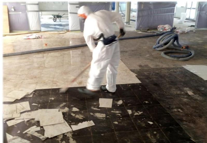
→ Arrachage de dalles de sol souples amiantées et/ou collées à la colle amiantée
