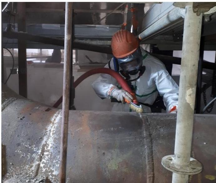
→ Grattage peinture pour réaliser un contrôle soudure
