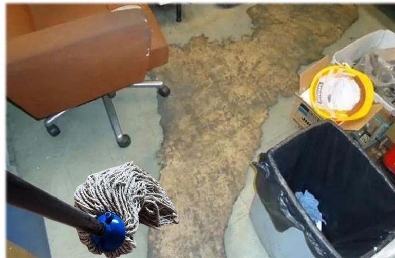
→ Entretien d'un sol souple collé à la colle amiantée dégradé
