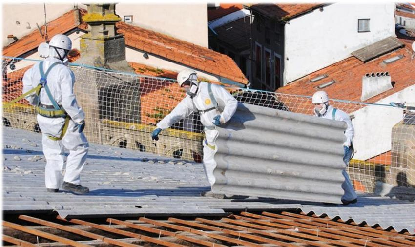
→ Démontage d'une couverture en plaques de fibrociment amianté
