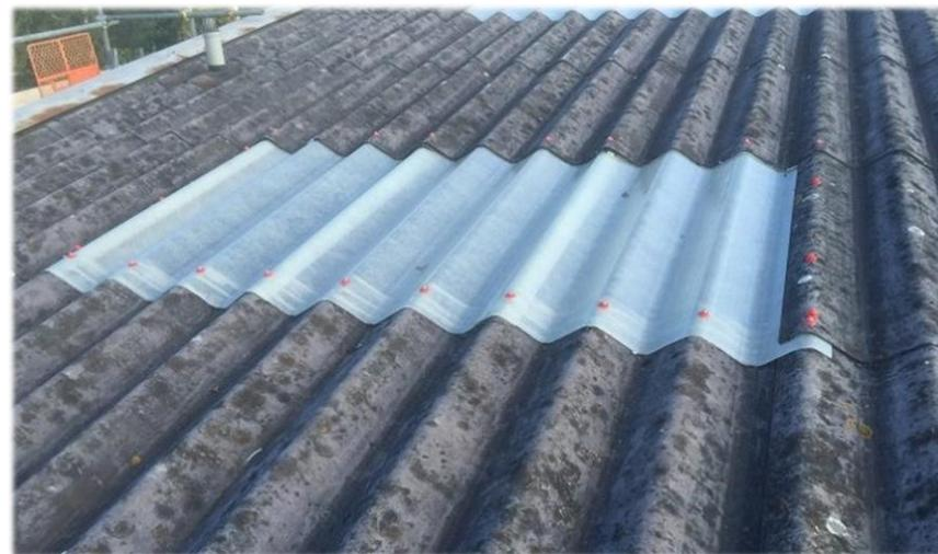
→ Remplacement d'une plaque de toiture en fibrociment amianté
