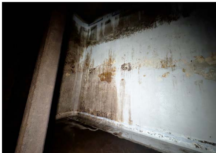
Figure 3 : vue d'un mur recouvert d'un revêtement d'étanchéité dans un ouvrage enterré de 3 200 m 3 (RAT en contexte Catec).
