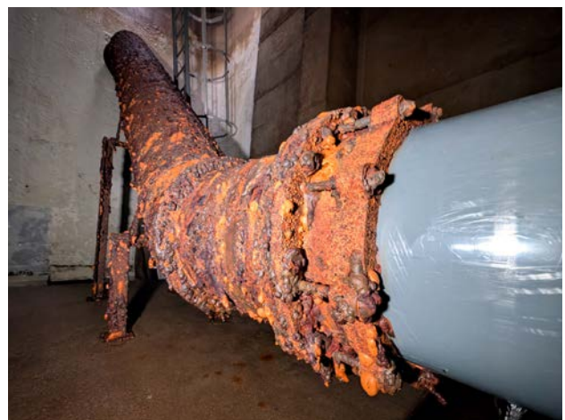
Figure 6 : conduite d'amenée d'eau dans un réservoir enterré de 3 200 m³.
