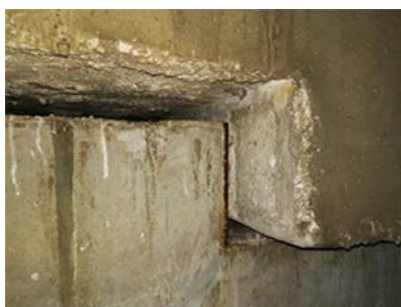
Figure 8 : pièce d'appui d'un ouvrage d'art (vue intrados).
