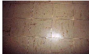
Dalles de sol
