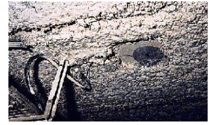
Flocages de plafond
