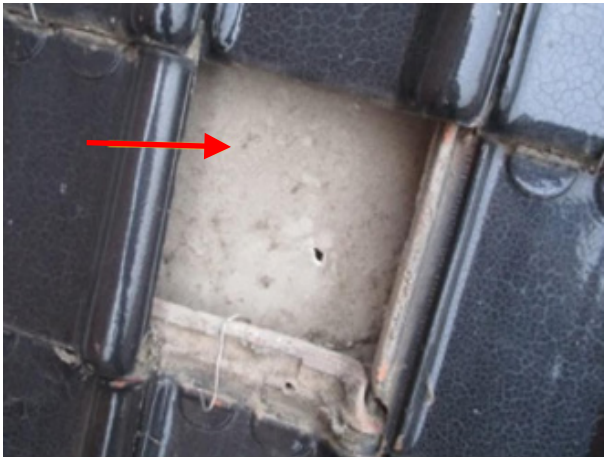
Onderdakplaat in “Menuiserite” Bron: OVAM
