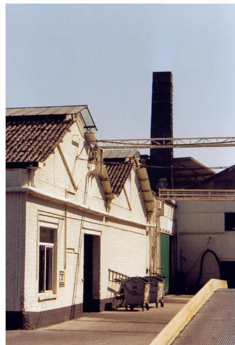
Golfplaten in asbestcement op bedrijfsgebouwen in Vilvoorde
