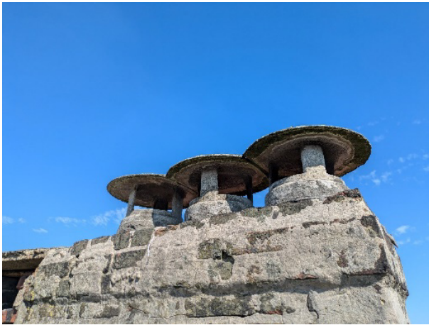
Schouwpijpjes in asbestcement
