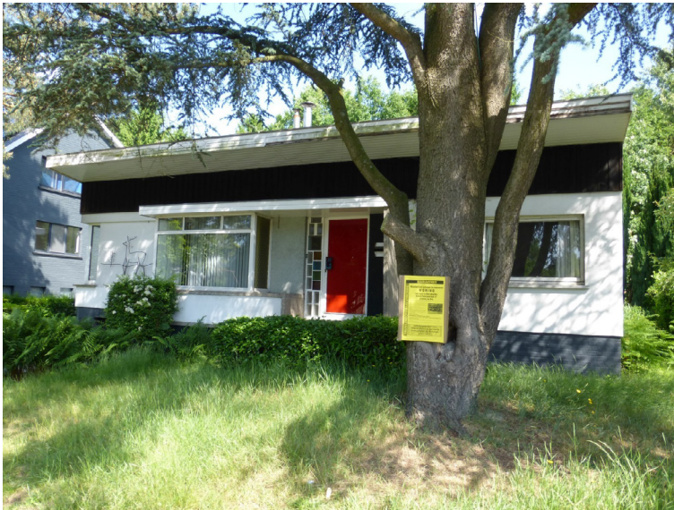
Deur in Glasal, modernistische bungalow in Drogen
