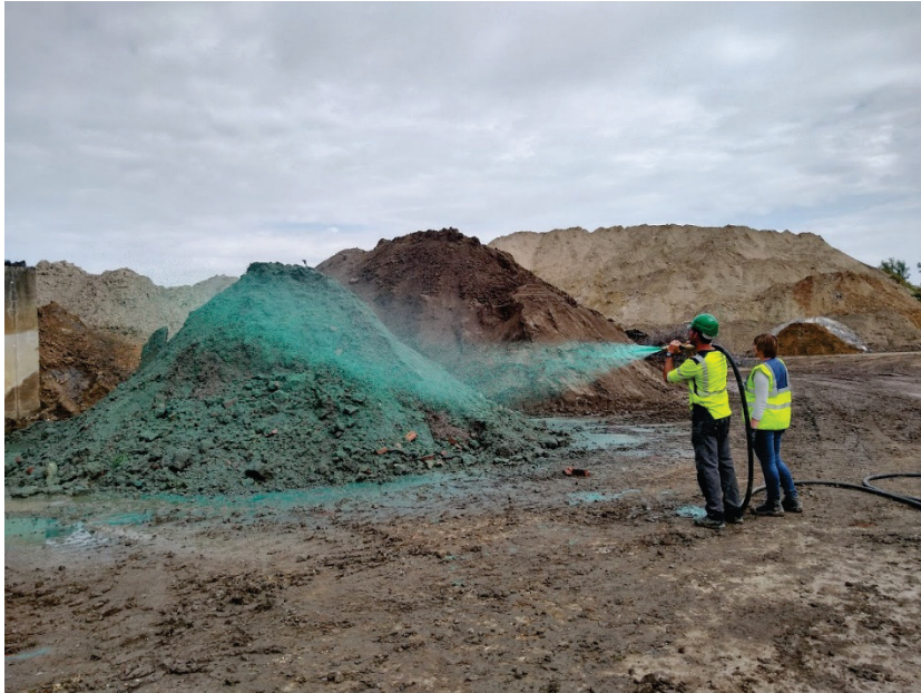
Figuur 32: Aanbrengen van biodegradeerbare korstvormer op asbesthoudende hoop
