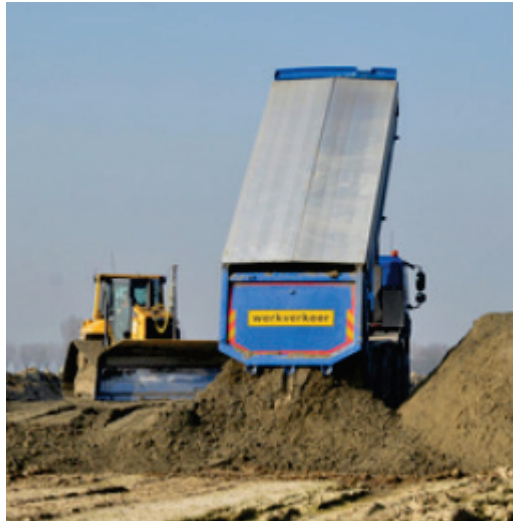
Figuur 28: Lossen van een kiepvrachtwagen met hydraulische kleppen om de lading af te dekken (Inspectie Leefomgeving en Transport, 2022)
