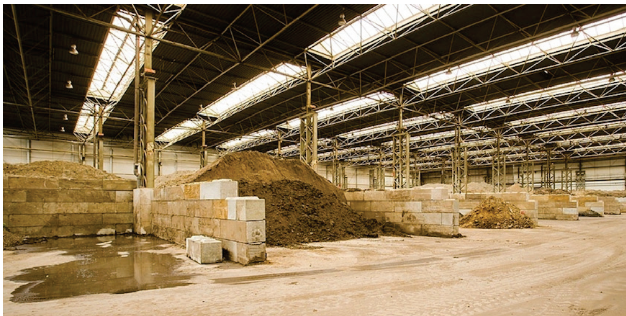
Figuur 10: Opslag van bodemmaterialen in overdekte winddichte hal, uitgerust met vloeistofdichte vloer en betonnen scheidingswanden (Aclagro, 2022)
