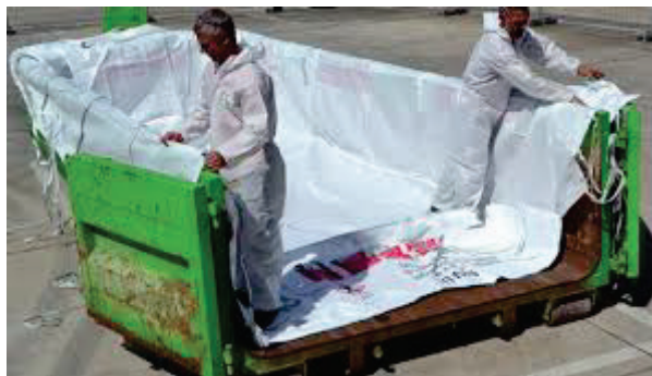
Figuur 30: Bevestigen van linerbag in een container (IVVO, 2023)
