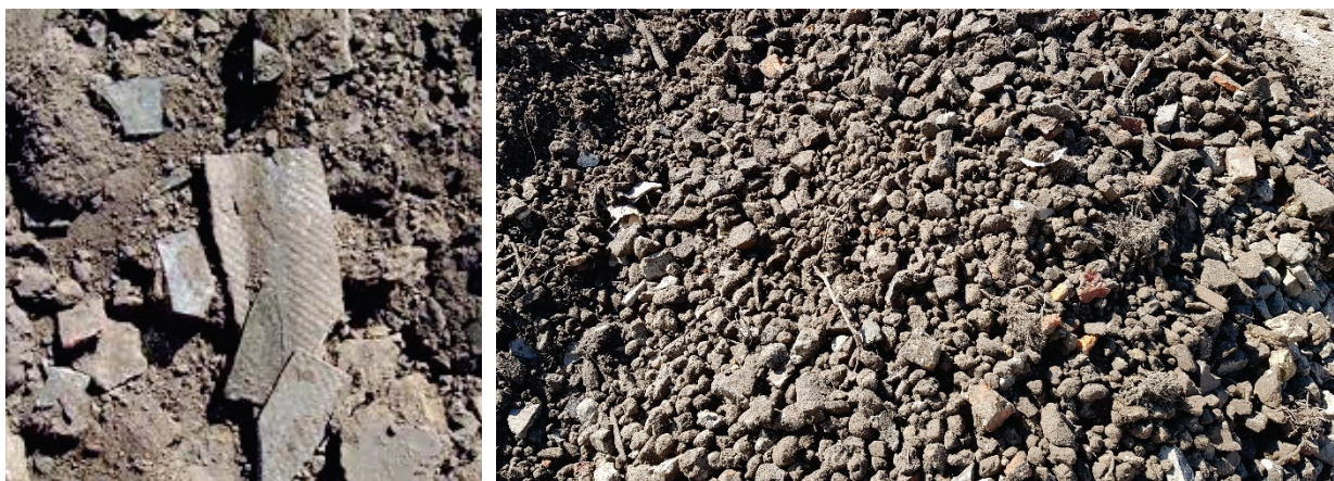
Figuur 6: Bodem en puin verontreinigd met asbesthoudend materiaal (OVAM, 2016)
