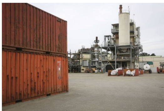
Figure 50 : Usine Inertam : vitrification par torche à plasma (Source : l'usine nouvelle)
