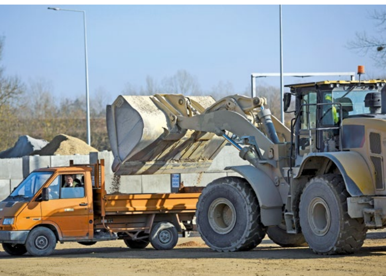
Figure 23. Chargement de matériaux minéraux inertes recyclés pour expédition
