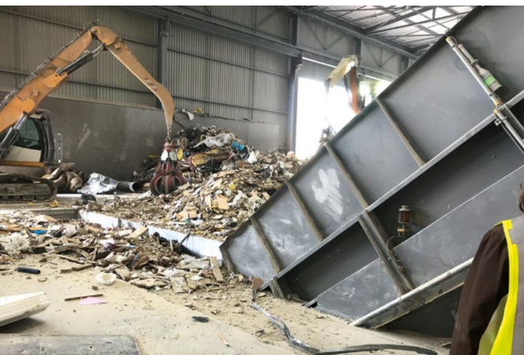
Figure 11. Déchets pré-triés et placés dans une fosse pour alimenter le convoyeur avec la pelle hydraulique équipée de grappin
