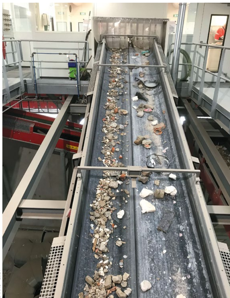
Figure 13. Répartition homogène sur le convoyeur des déchets issus du criblage avant leur entrée en cabine de tri manuel
