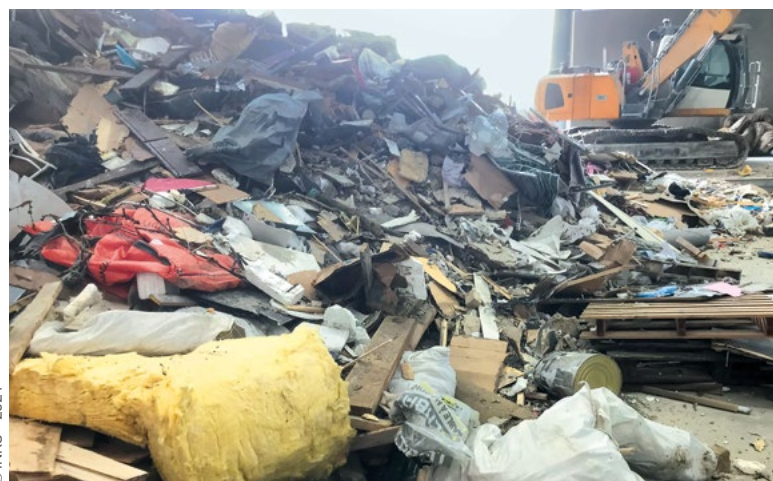
Figure 10. Exemple de déchets de chantier collectés en mélange nécessitant un pré-tri mécanique à la pelle hydraulique équipée de grappin
