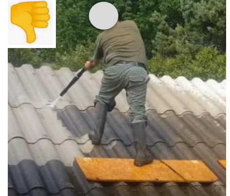
Démoussage toiture fibrociment
