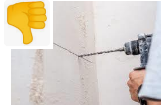
Percement d'un mur avec du plâtre amianté
