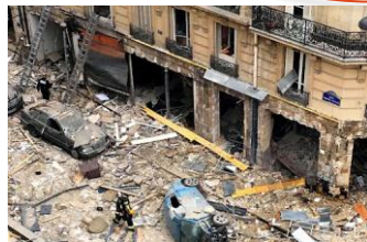
Risques liés aux canalisations et réseaux non-détectés, non-consignés (Ex: Fuite de Gaz)
