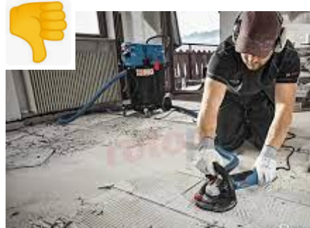
Ponçage de la colle amiantée avant la pose d'un nouveau ragréage/colle ...
